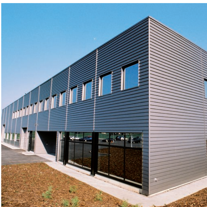
Bâtiment de CP Automation.
